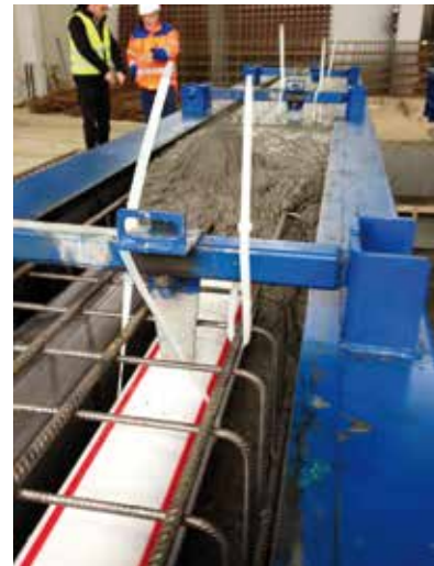
Bild 4: Betonieren des Rohrblock-Elements.
