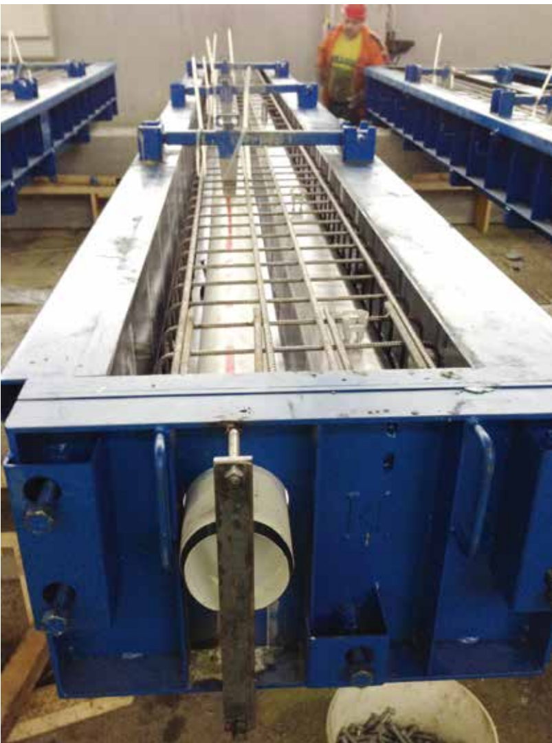
Bild 3: Einbringen des KS-Rohres in Schalung.
