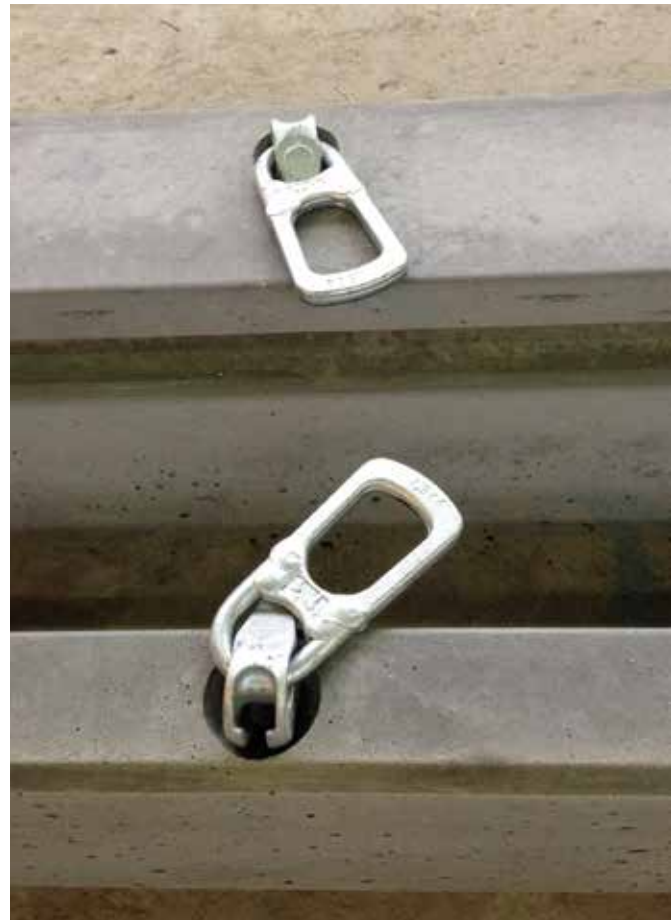
Bild 9: Spezialaufhängung als Einbauhilfe.
