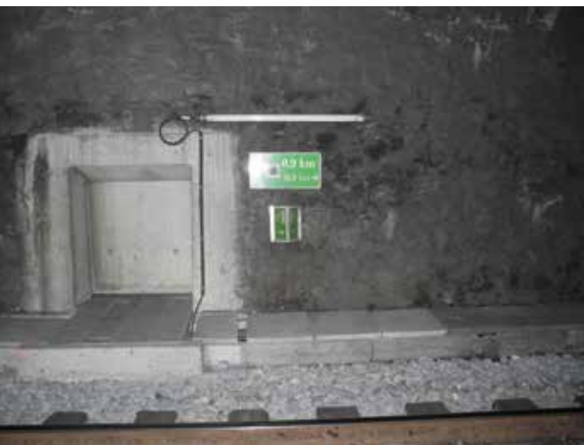
Bild 11: Rohrblock mit Abdeckplatten.
