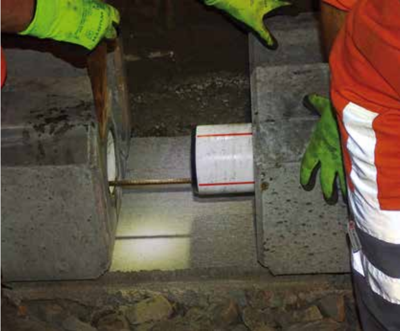
Bild 8: mm-genaue Verbindung der Rohrblöcke.
