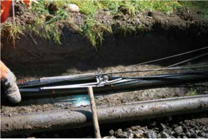
Nahaufnahme der Längverschlussöffnung mit Einzugschlitten Détail de l'ouverture de la fermeture longitudinale avec tire-fil Ripresa riavvicinata dell'apertura longitudinale con slitta di trazione
