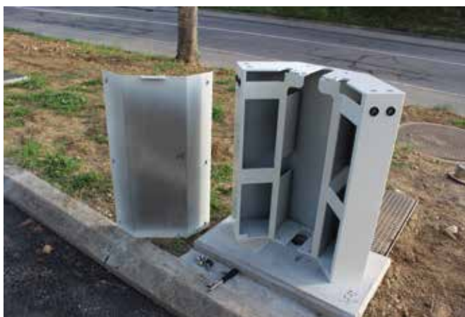
Blechabdeckung, vor Montage.
